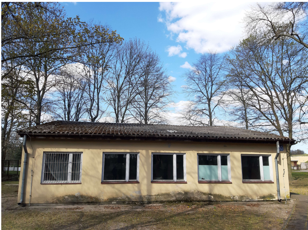
Zdjęcie nr 5 – budynek nr 30 elewacja wschodnia
