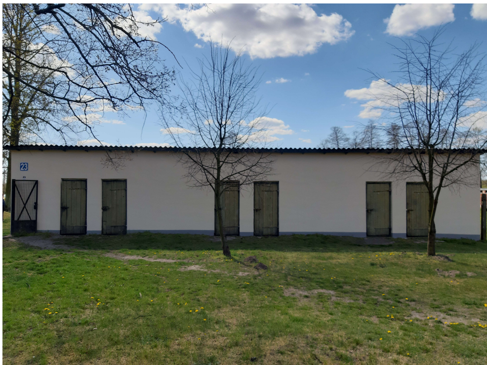
Zdjęcie nr 1 – budynek nr 23 elewacja północna
