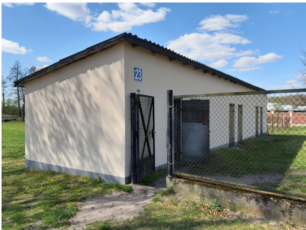
Zdjęcie nr 2 – budynek nr 23 elewacja wschodnia
