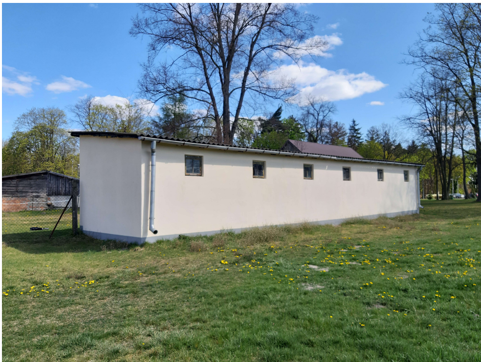
Zdjęcie nr 3 – budynek nr 23 elewacja południowa
