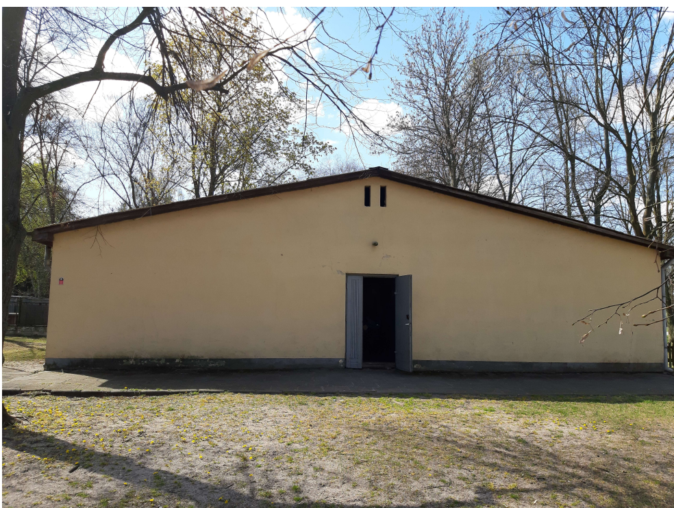
Zdjęcie nr 6 – budynek nr 30 elewacja północna
