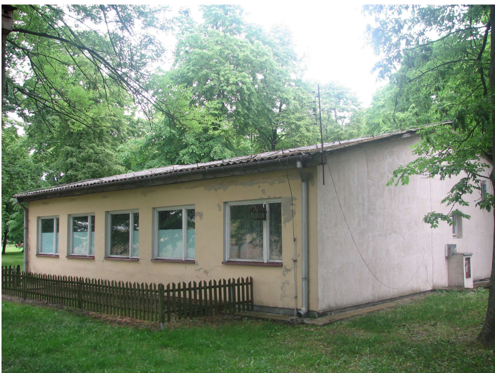
Zdjęcie nr 4 – budynek nr 30 elewacja zachodnia
