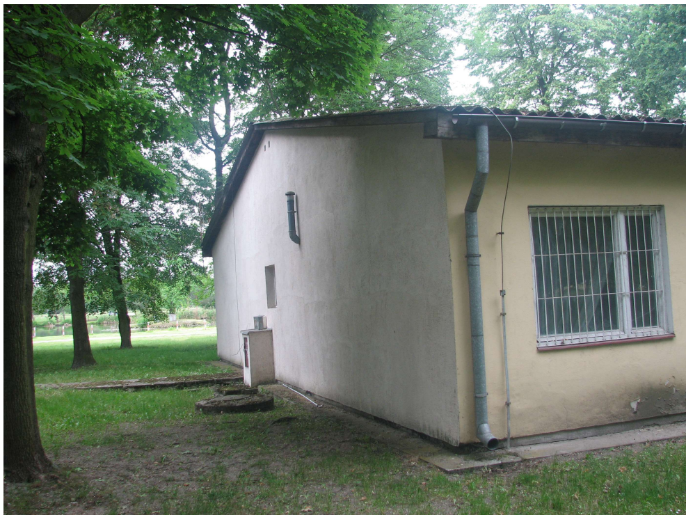
Zdjęcie nr 7 – budynek nr 30 elewacja południowa
