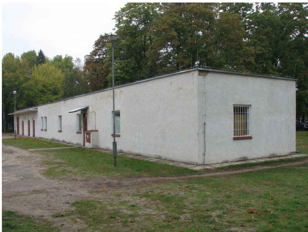
Zdjęcie nr 1 – budynek nr 19 elewacja południowa i zachodnia
