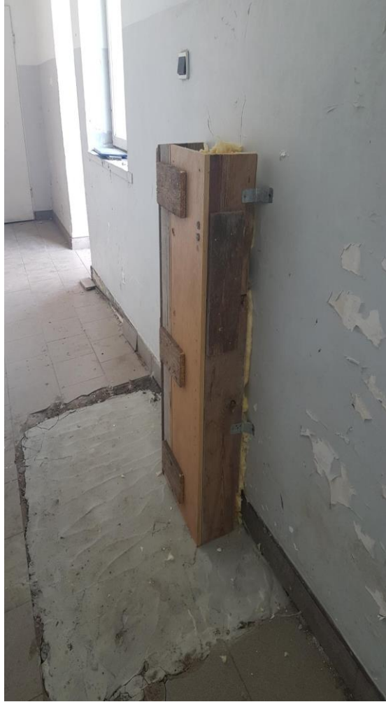
Zdjęcie nr 3 – budynek nr 19 przyłączy wodociągowe
