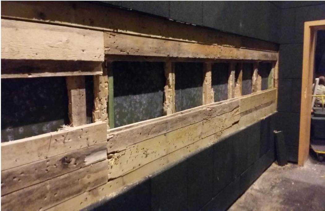
Zdjęcie nr 5 – ściana po zdjęciu płyt
