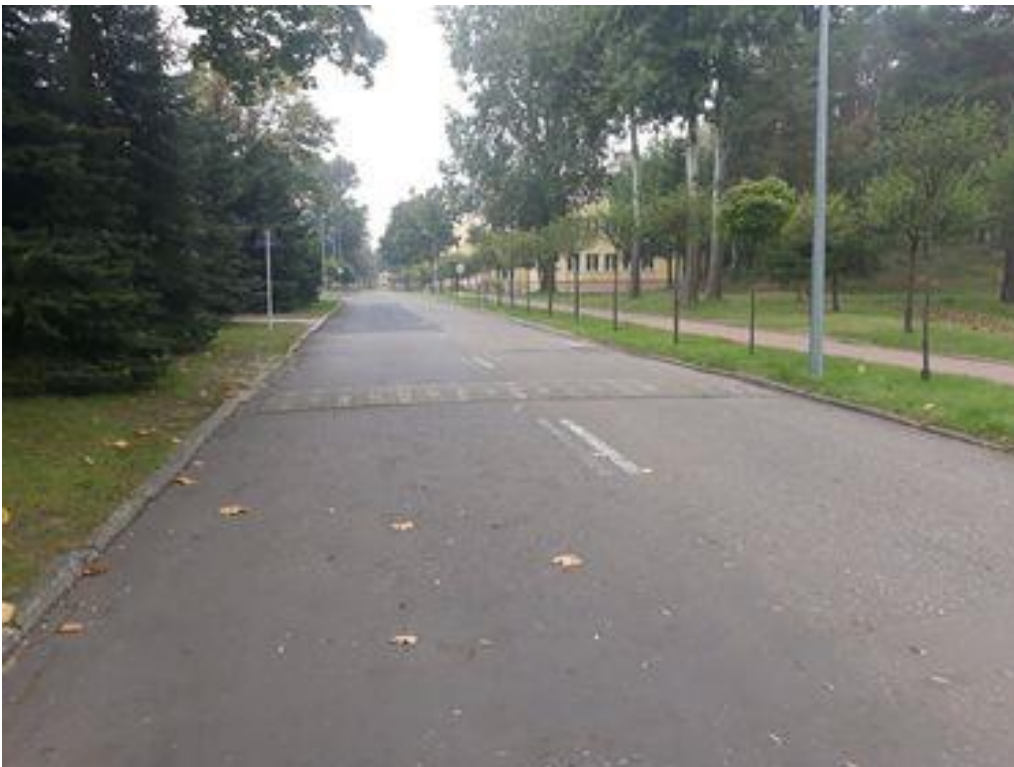
Zdjęcie nr 2 – droga od skrzyżowania do budynku nr 47
